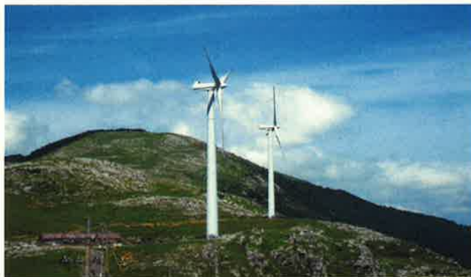
四国カルスト天狗高原山頂 近くにある 2 基の風力発電 (写真提供：梶原町)
